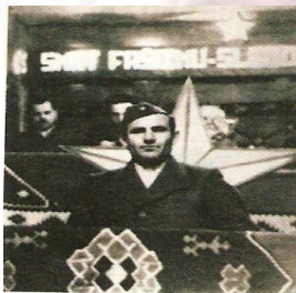
Sa prvog zasjedanja ZAVNOBIH-a 1943.
